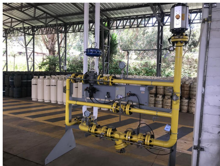
Instalación del Skid de Regulación de GLP
