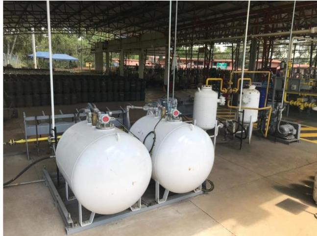
**Instalación de equipo para pruebas hidrostáticas de cilindros de GLP**
