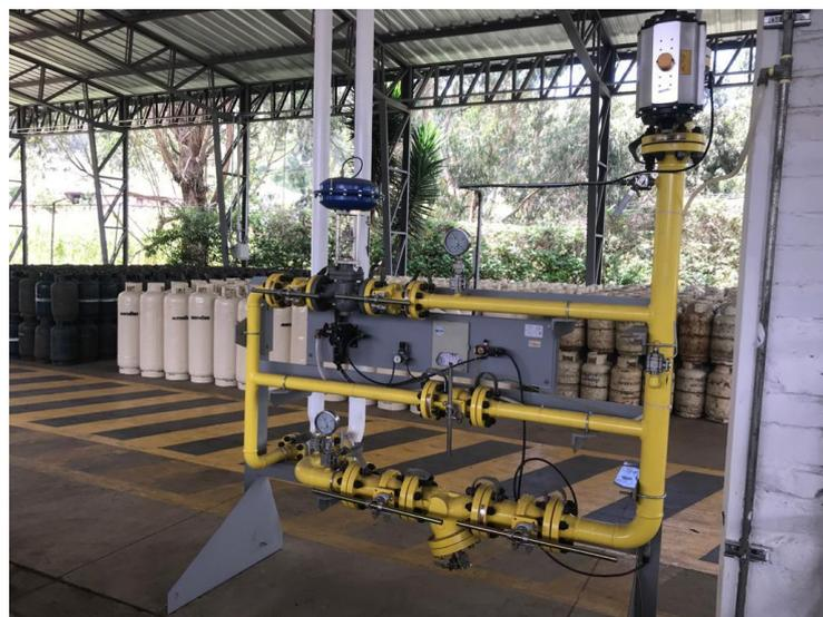
**Instalación de equipo de evacuación de GLP de cilindros para mantenimiento**
